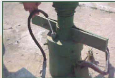
F.1 Instalação do medidor.
